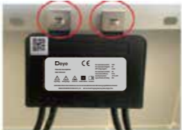
Abb. C: Befestigung des Optimierers
